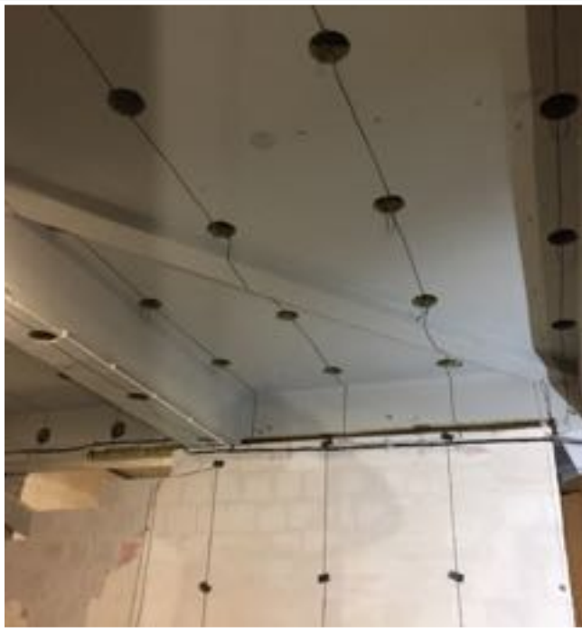
Budowa systemu zabezpieczenia wibroakustycznego, na zdjęciu faza montażu przetworników wibroakustycznych PIEZO.
