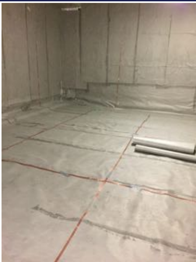
Budowa ekranu elektromagnrtycznego.
