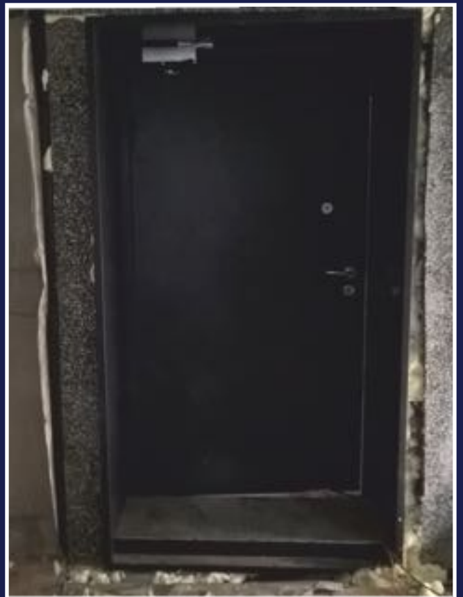
Montaż śluzy akustyczno-elektromagnetycznej.
