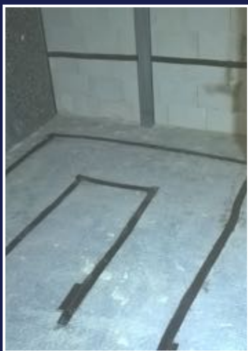
Trasy sieci przetworników Piezo.
