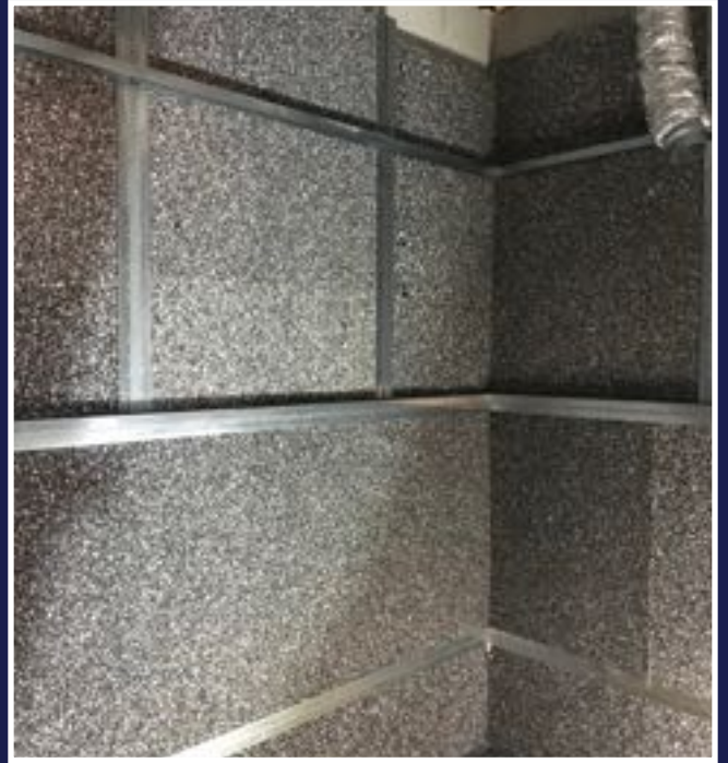
Budowa ekranu akustycznego.
